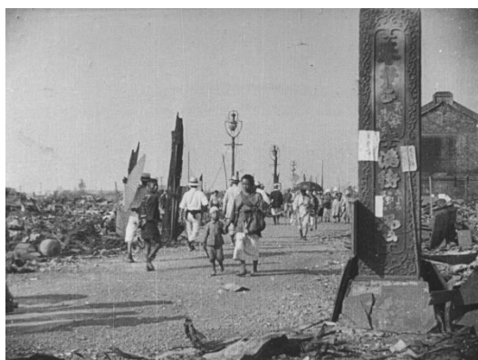
場所：台東／シーン：焼失,倒潰・損壊
