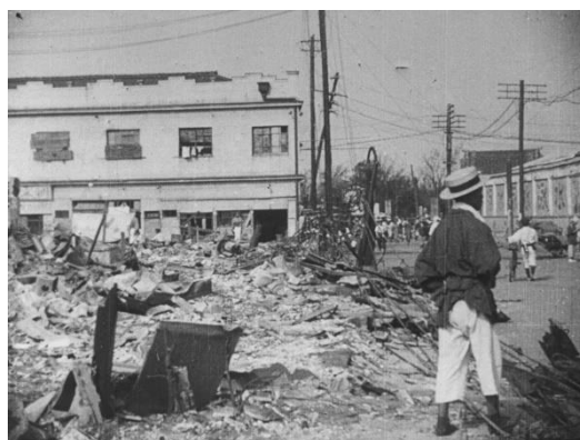
場所：台東／シーン：焼失,倒潰・損壊
