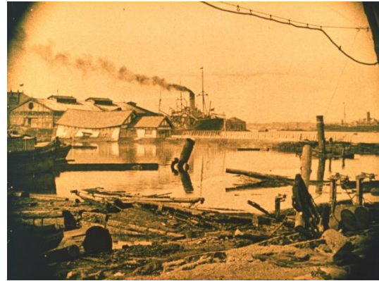
場所：横浜／シーン：焼失、倒潰・損壊
