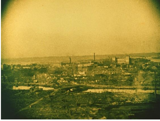
場所：横浜／シーン：焼失、倒潰・損壊
