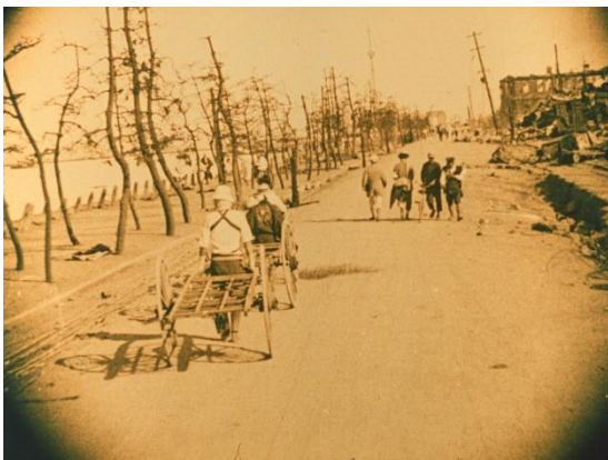
場所：横浜／シーン：焼失、倒潰・損壊
