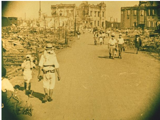
場所：横浜／シーン：焼失、倒潰・損壊
