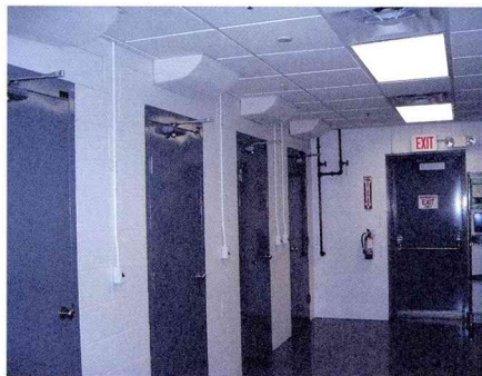
ナイトレート・フィルムの保管室(前室)
