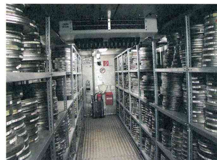
オーバーザイン： [右上]可燃性フィルム保存施設 [右下]可燃性フィルム保存庫内部
